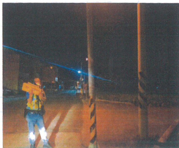
3-4 如意路六股大牌橋頭施工(中)
