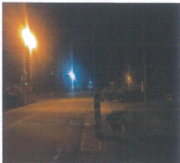
3-3 說明：如意路六股大牌橋頭施工（前）
