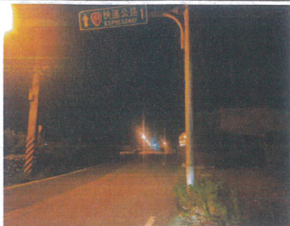
3-1 說明：裝置雙報閃燈施工(前)
