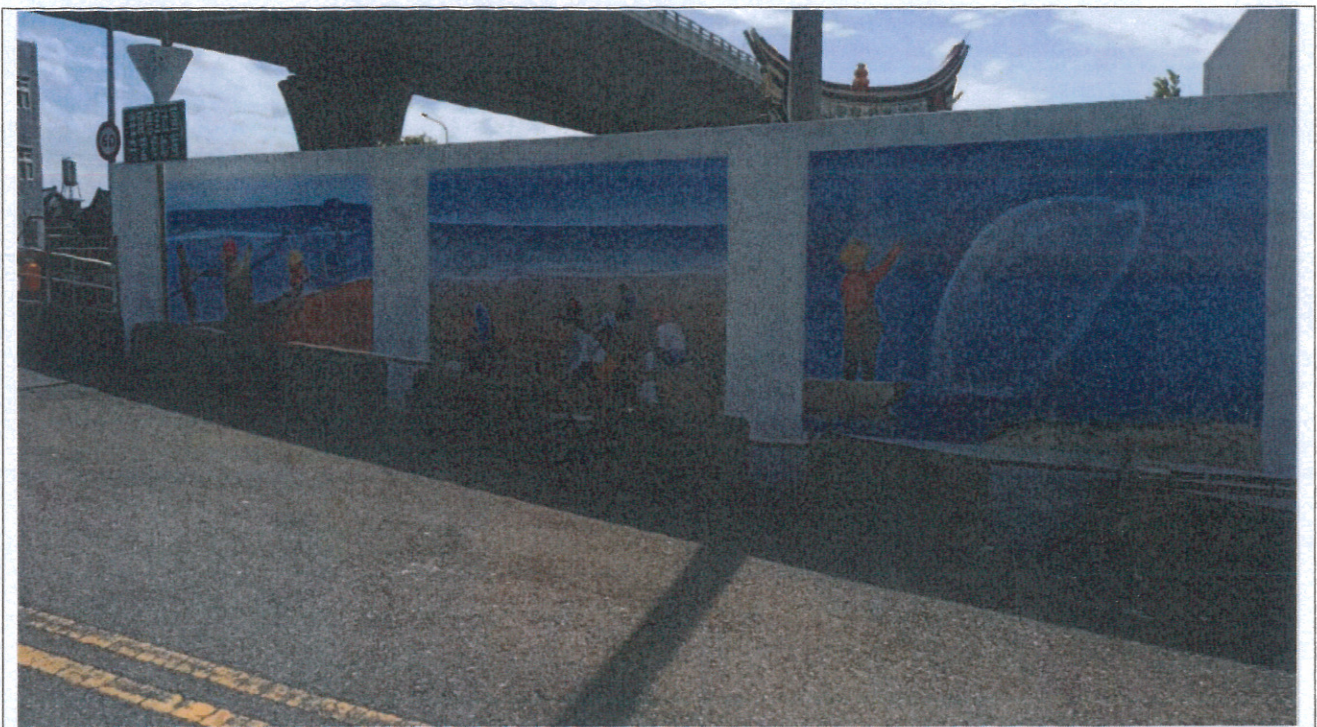
圖片說明：施工前
