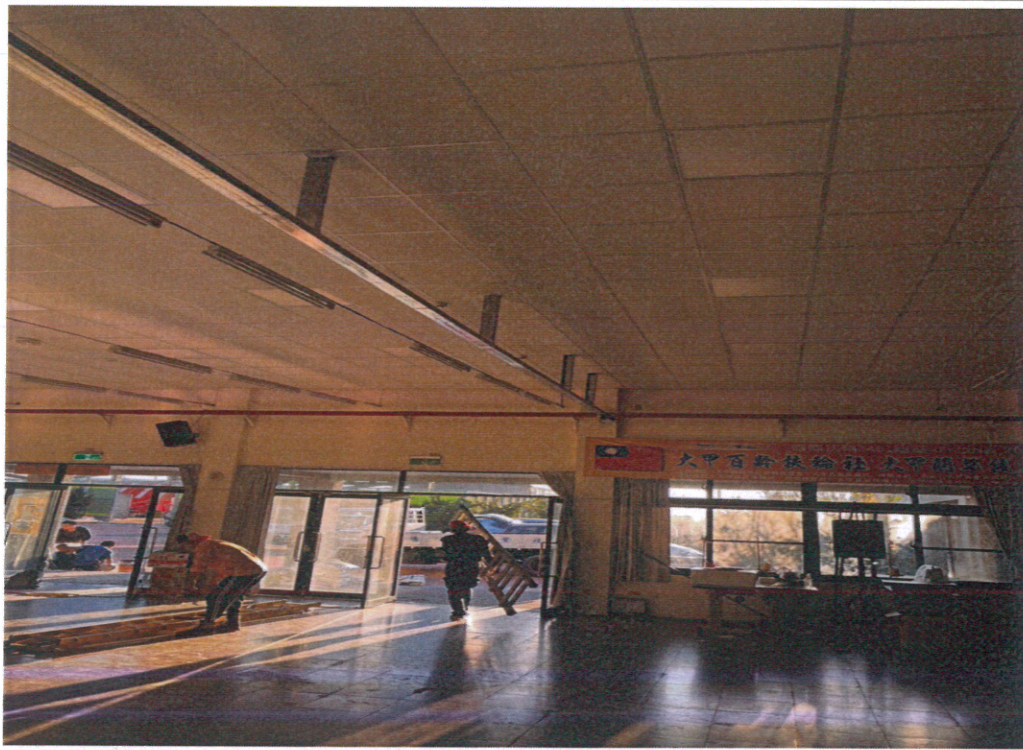
圖片說明：施工中
