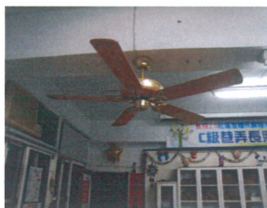
說明：更換安裝中
