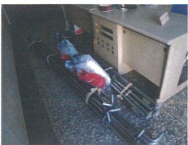
說明：7. 設備組裝前
